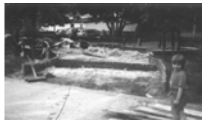
Anlage eines großzügigen Sandkastens mit Douglasienabschnitten als Umrandung – Grundschule Meine
